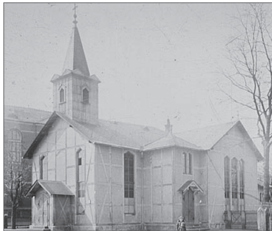
- Die einstige Interimskirche auf der Hebbelstraße -
