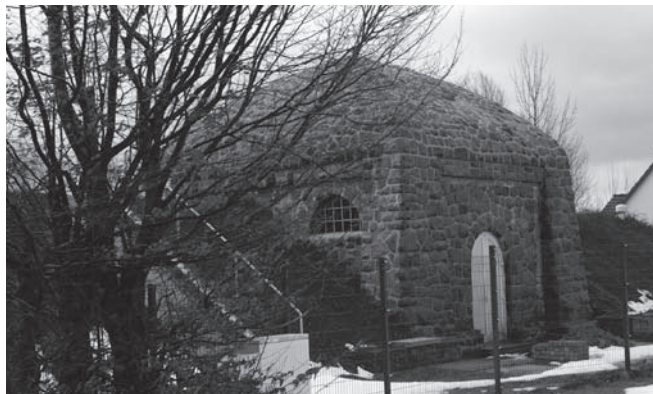
- Hochbehälter in Altfranken -
