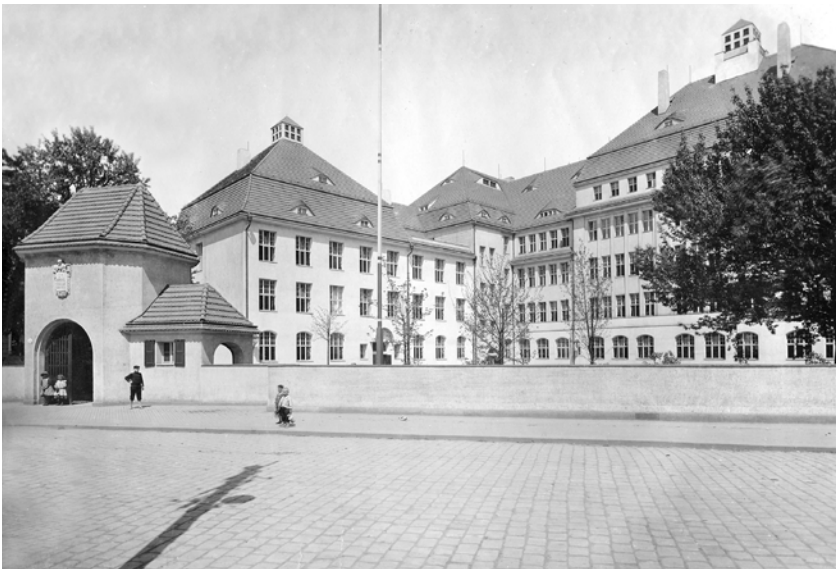
- Ansicht von der Cossebauder Straße aus - (Foto: Stadtplanungsamt)
