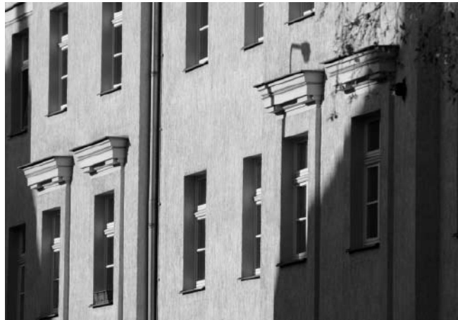
Fenstergestaltung mit gründerzeitlicher Anmutung
