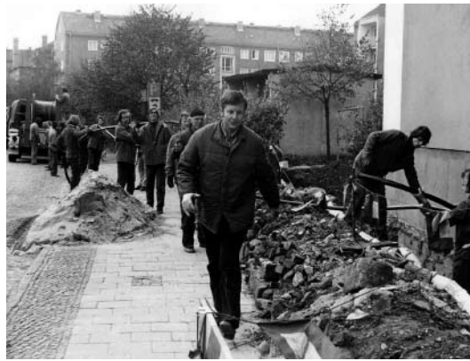
Arbeiten auf der Zöllmener Straße
