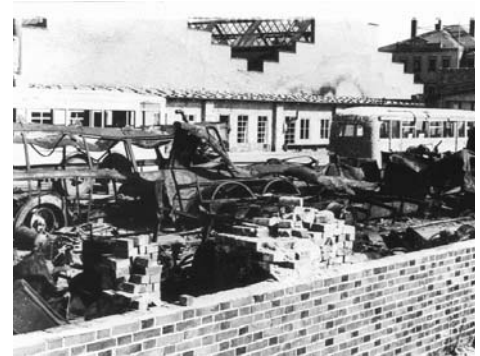
Omnibus-Betriebshof Naußlitz im Jahre 1946: Die Trümmer sind beseitigt und die Werkstatt provisorisch hergerichtet, ausgebrannte Omnibuswracks sind zum Ausschlachten abgestellt. Der Sattelschlepper-Omnibus Typ Opel-Blitz 3,5 Baujahr 1942 Nr. 222 ist als Schienenersatzverkehr für Linie 20 nach Leutewitz beschildert. Er wurde mit dem Kreis Fürstenwalde gegen Reifen getauscht, um die Obuslinie in Betrieb nehmen zu können! Foto: Archiv A. Arldt †
