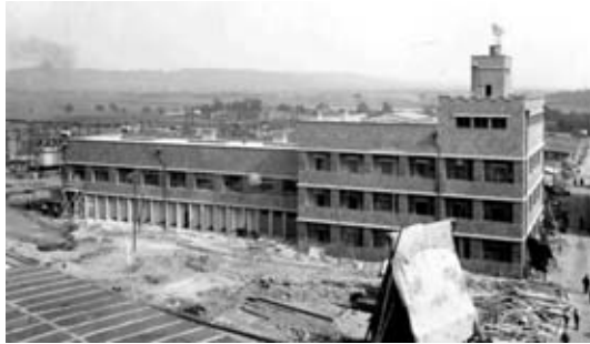
Das Kraftwerk noch im Bau.
