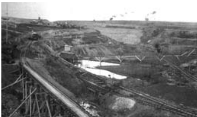
Bau des oberen Staubeckens ca. 1929.
