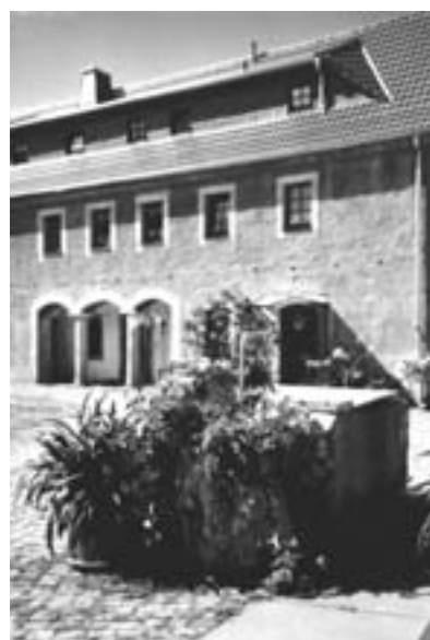
Heimatseite im Vierseitenhof von Richters in Zöllmen.
